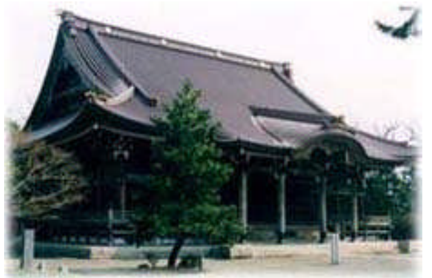
屋根のふき替えも終わって綺麗になった本堂
